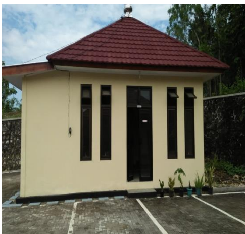
Pembangunan mushola pasar Dlingo Rehab pasar Piyungan
