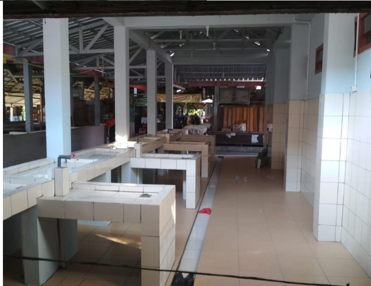
Rehab pasar Panasan, los ikan pasar Imogiri, paving block pasar Bantul
