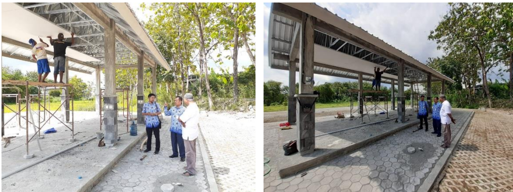
Proses pembangunan tempat kuliner Banguntapan
