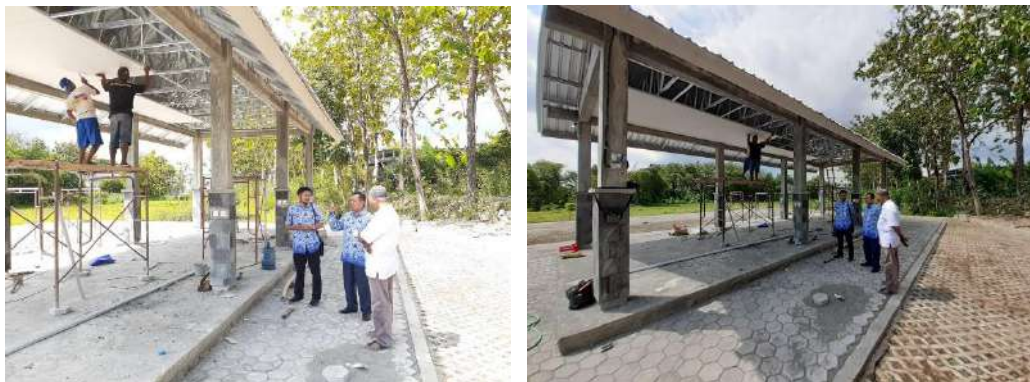
Proses pembangunan tempat kuliner Banguntapan
