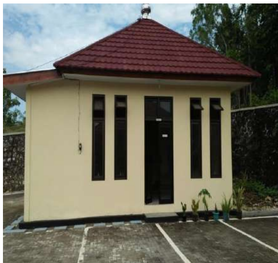
Pembangunan mushola pasar Dlinao Rehab pasar Piyungan
