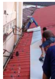
Rehabilitasi Talang air Pasar Bantul,
