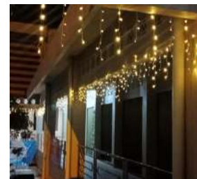
Pemasangan Lampu Pasar Bantul
