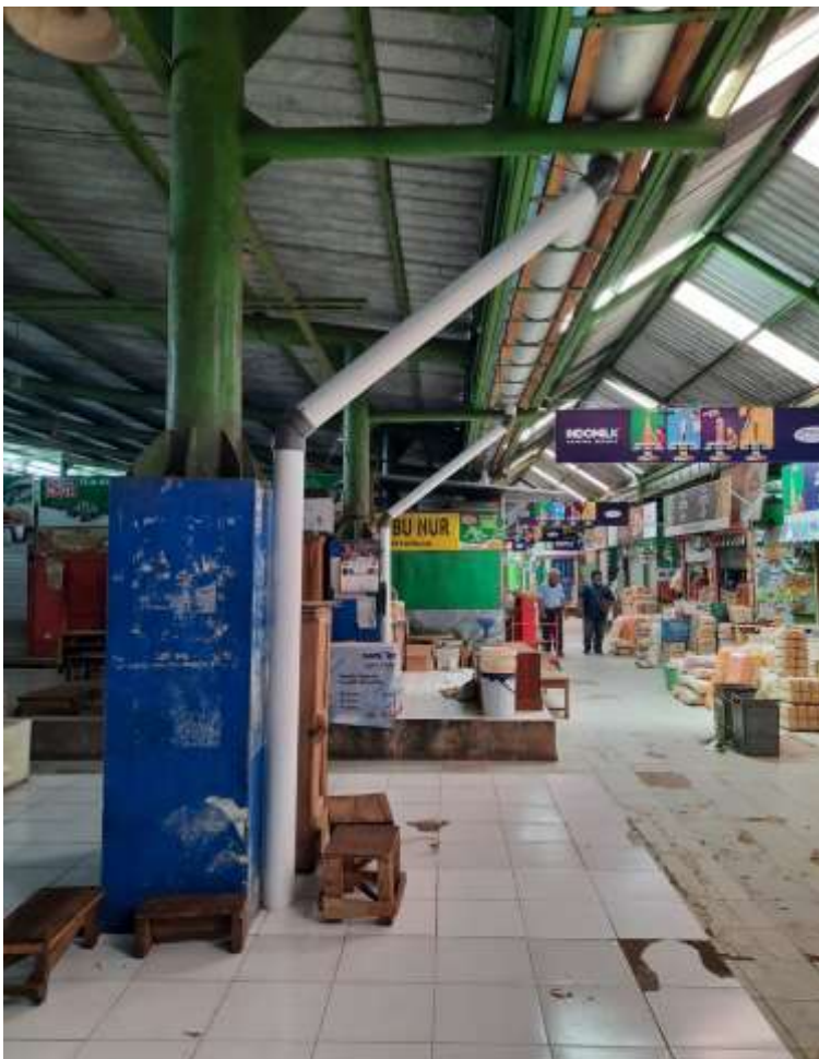
Rehabilitasi Pasar Piyungan
